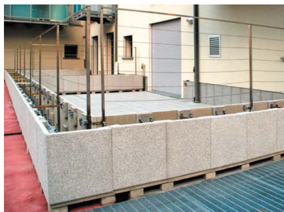
Grillage avec fils en acier inoxydable Espalderas con hilo de acero inoxidable
